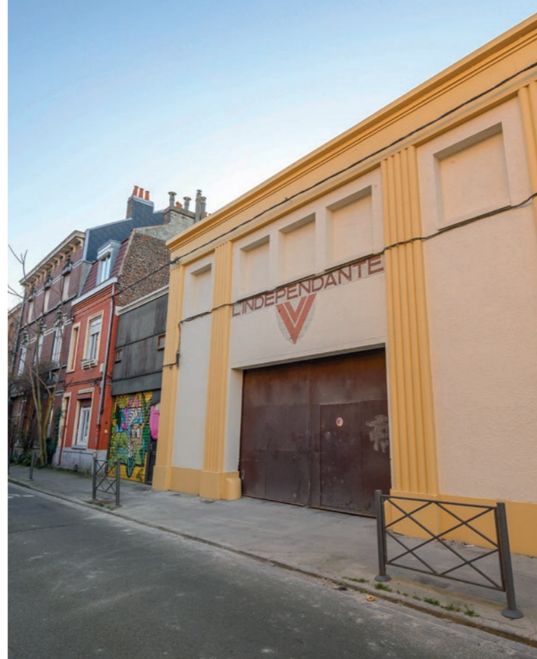
Réhabilitation d'un garage pour la création du tiers-lieux "L'Indépendante", NPNRU Lille Quartiers Anciens @Pierre Rogeaux
