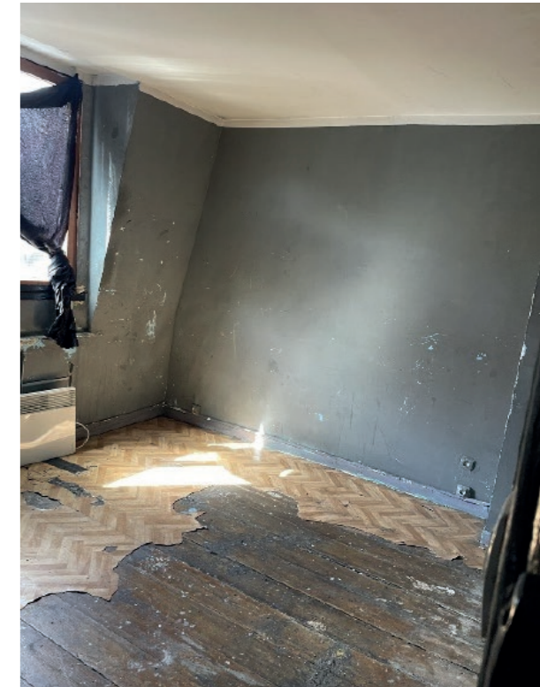
Vue du premier logement à traiter dans le cadre du mandat Travaux d'office à Roubaix @La fabrique des quartiers
