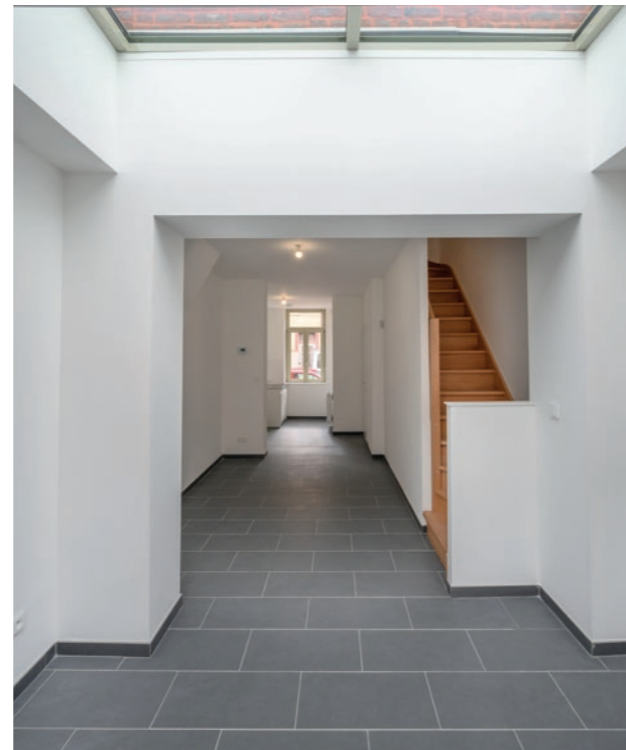
Réhabilitation d'un immeuble sous MOA SPLA, PMRQAD Pile à Roubaix / DBO @Pierre Rogeaux
