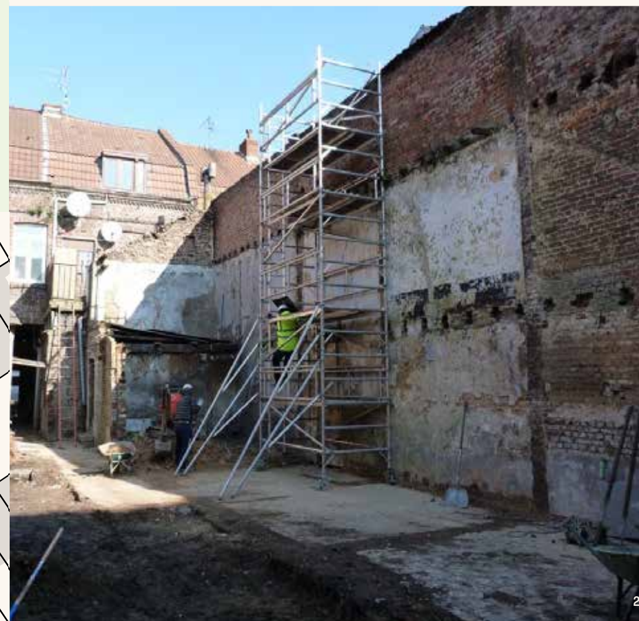
1. Vue de la cour Henri Pollet avant les travaux de déconstruction 2. Vue de la cour Henri Pollet pendant les travaux de déconstruction
