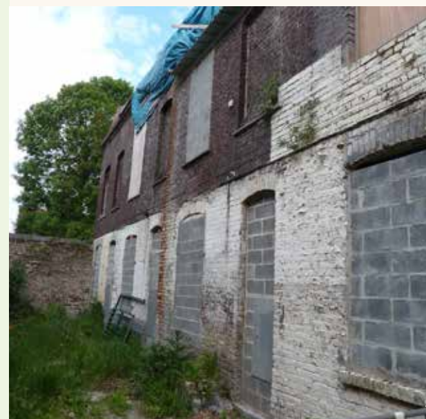
3 & 4. Vue de la cour Saint-Antoine avant et après les travaux de déconstruction
