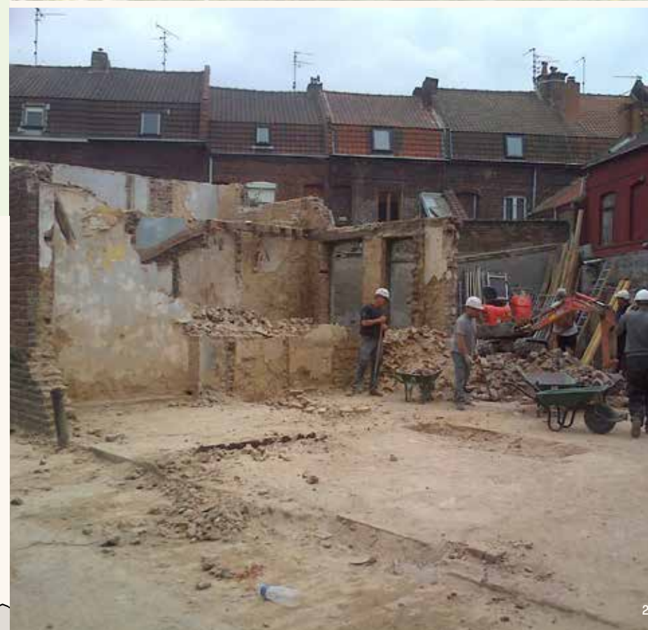
1. Vue de la cour Verfaillie avant les travaux de déconstruction 2. Vue de la cour Verfaillie pendant les travaux de déconstruction
