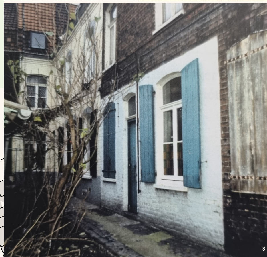
1 & 2. Vue de la cour Vandebosche avant et après les travaux de déconstruction 3. Vue de la cour Deschamps au début des années 1990 @MEL
