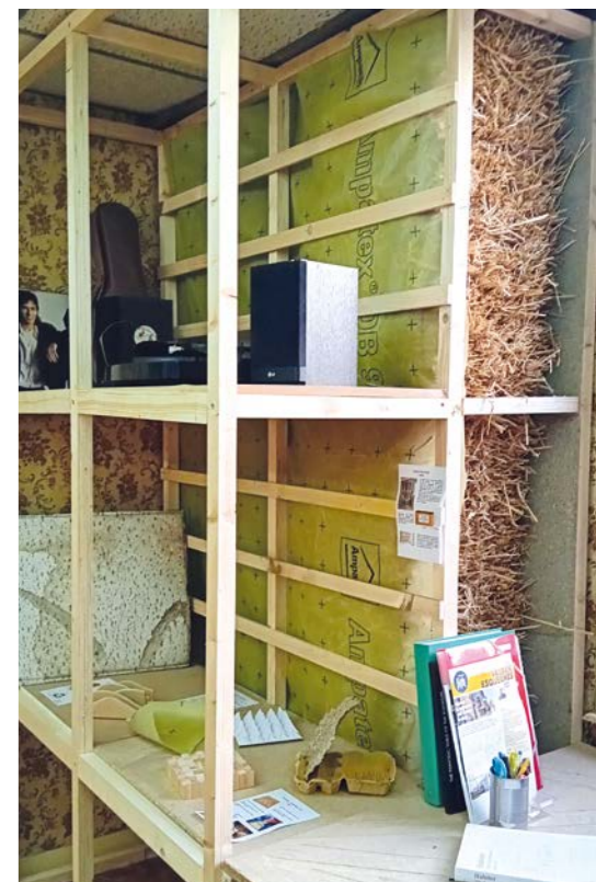
Travail autour d'une pièce multi-usages : musique, bureau...
