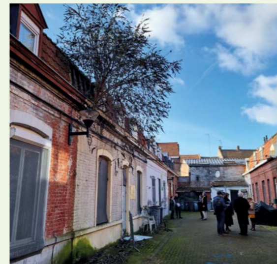
Maisons à réhabiliter Cour Catteau, PMRQAD Bayard
