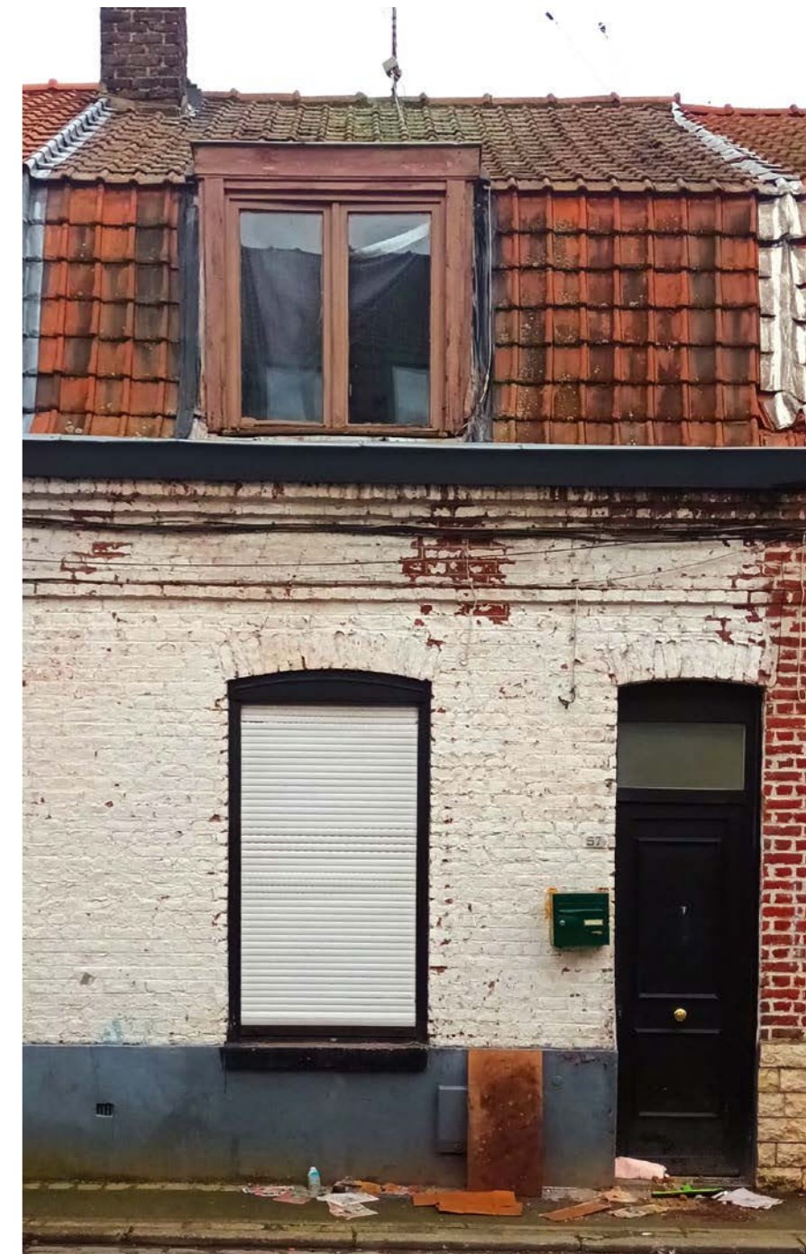
Maison à réhabiliter dans le cadre du mandat de travaux d'office
