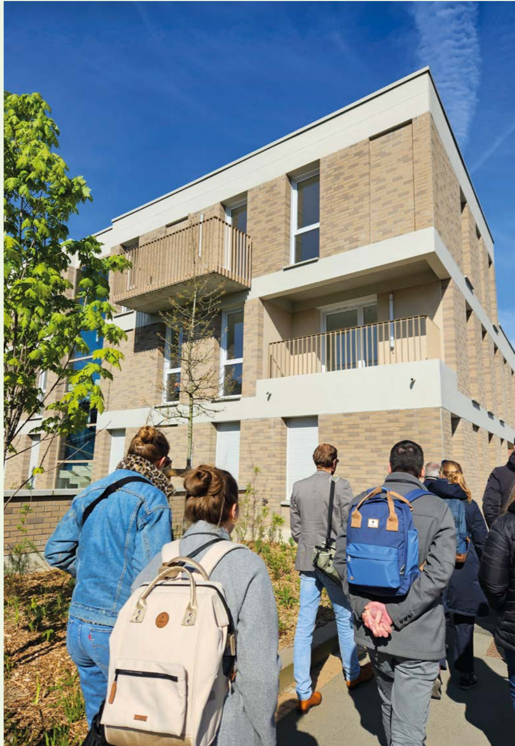
Visite des constructions neuves sous MOA KIC - Vilogia - Vilogia Premium / dbo architectes
