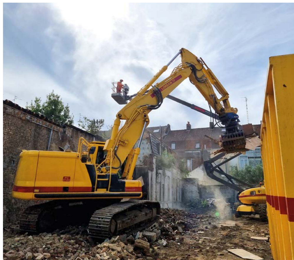
Chantier de déconstruction de la courée Perche-Croix à Roubaix - 7 e tranche RHI
