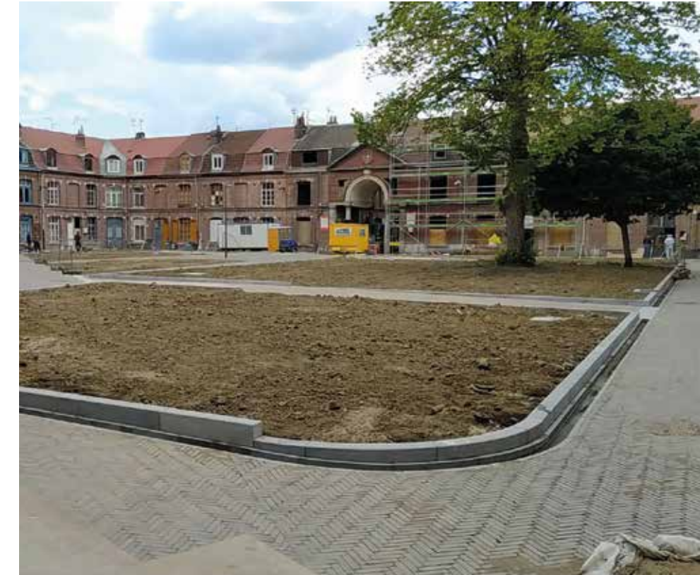
Travaux d'aménagement de l'espace central de la Cité Saint-Maurice.
