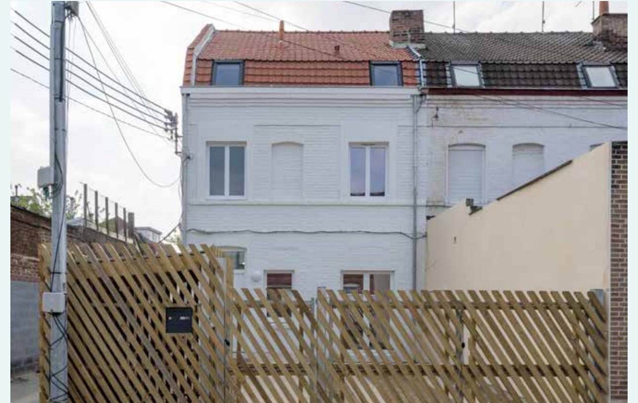
Réhabilitation d'un immeuble sous MOA SPLA pour SIA Habitat - Wattrelos / sam.banchet ©Pierre Rogeaux
