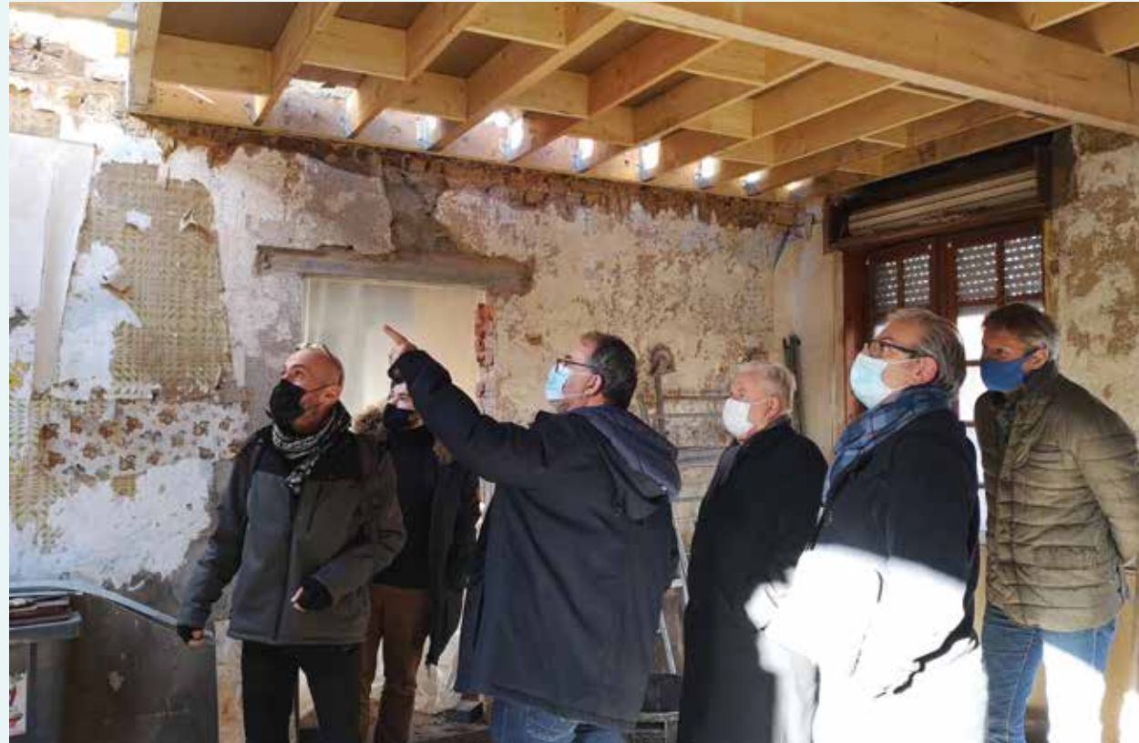
Visite d'un immeuble en cours de réhabilitation.
