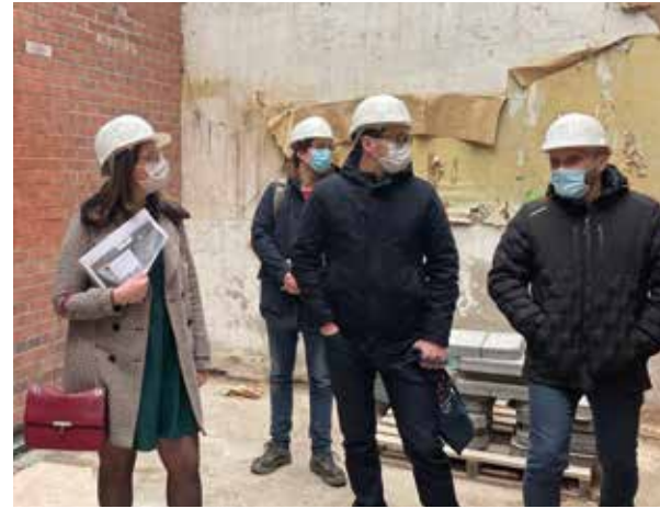
Visite chantier de réhabilitation Tourcoing
