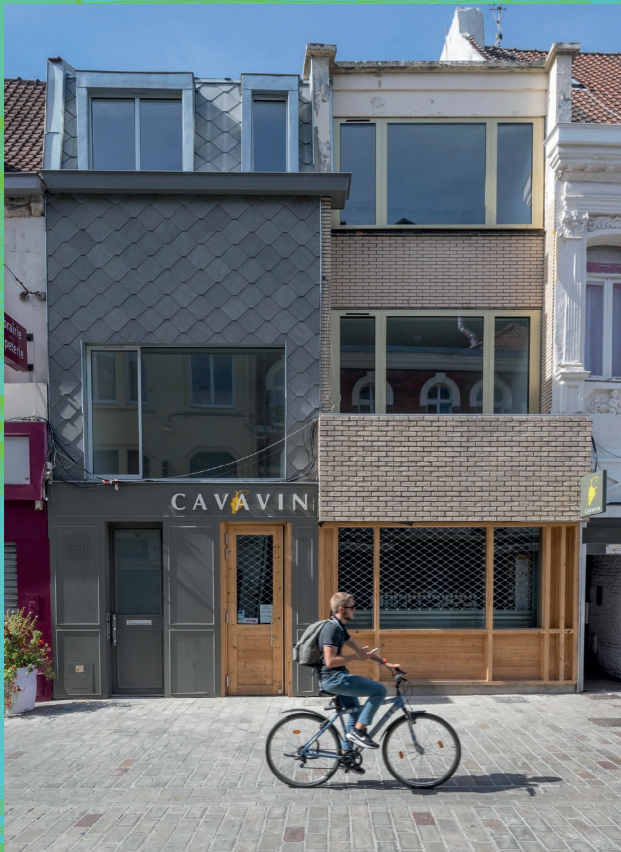
Réhabilitation d'un immeuble et d'un commerce sous MOA SPLA, Tourcoing Centre-ville / sam.banchet @Pierre Rogeaux
