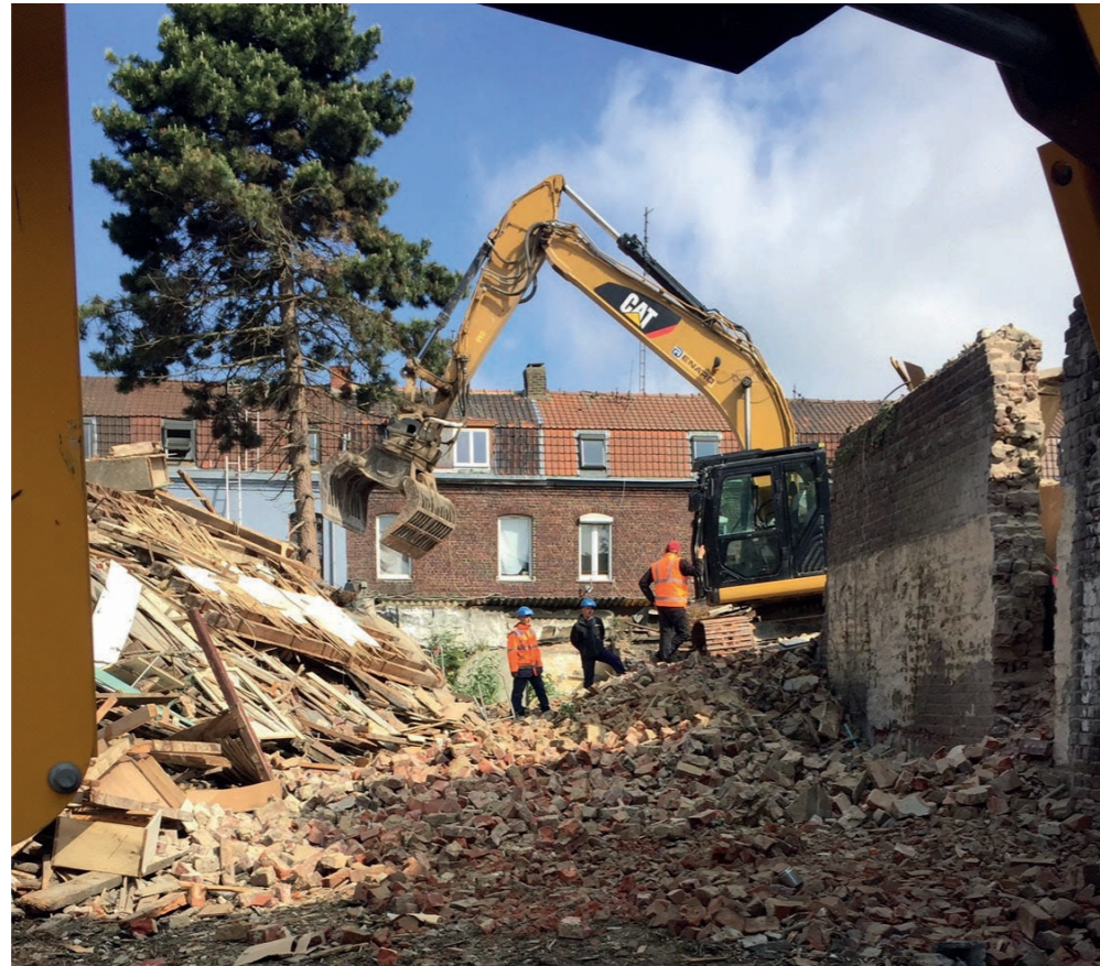
Démolition d'une courée à Roubaix, RHI
