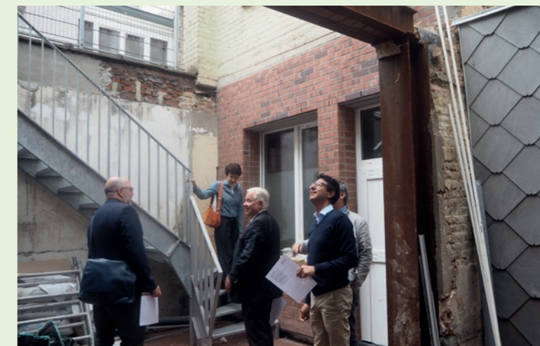
Visite de réhabilitations sous MOA SPLA, Tourcoing Centre-ville
