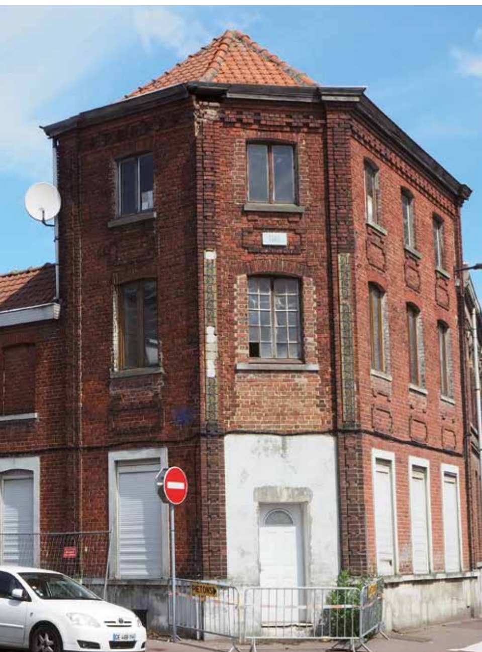
Exemple de logement vacant.
