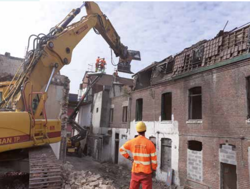
Chantier de démolition de la cour Vanbeveren.
