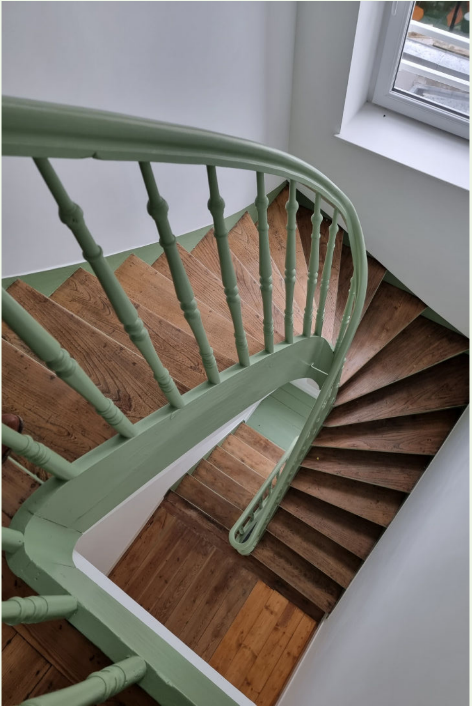
Réhabilitation d'un immeuble sous MOA SPLA - Lille Quartiers Anciens / Architecte : Plato
