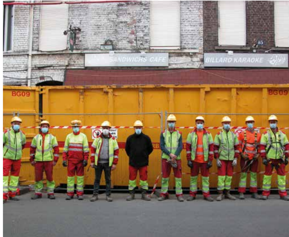
Chantier Vanbeveren @entreprise Lorban
