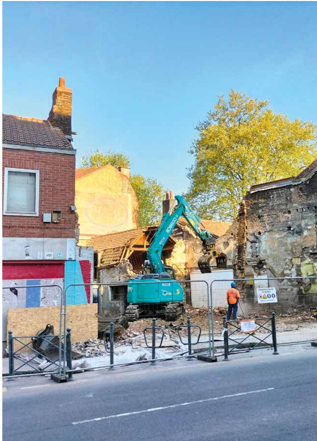
Déconstruction menée par Oria promotion pour la réalisation d'une dizaine de logements et en rdc le nouveau bureau de poste du quartier Moulins Lille quartiers anciens / sam.banchet.
