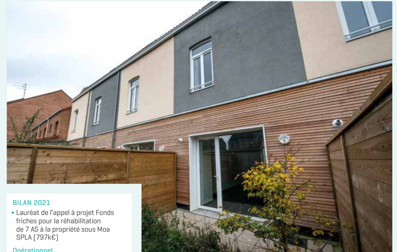
Réhabilitation d'un immeuble sous MOA SPLA – Roubaix- dbo architectes. @Sébastien Jarry.
