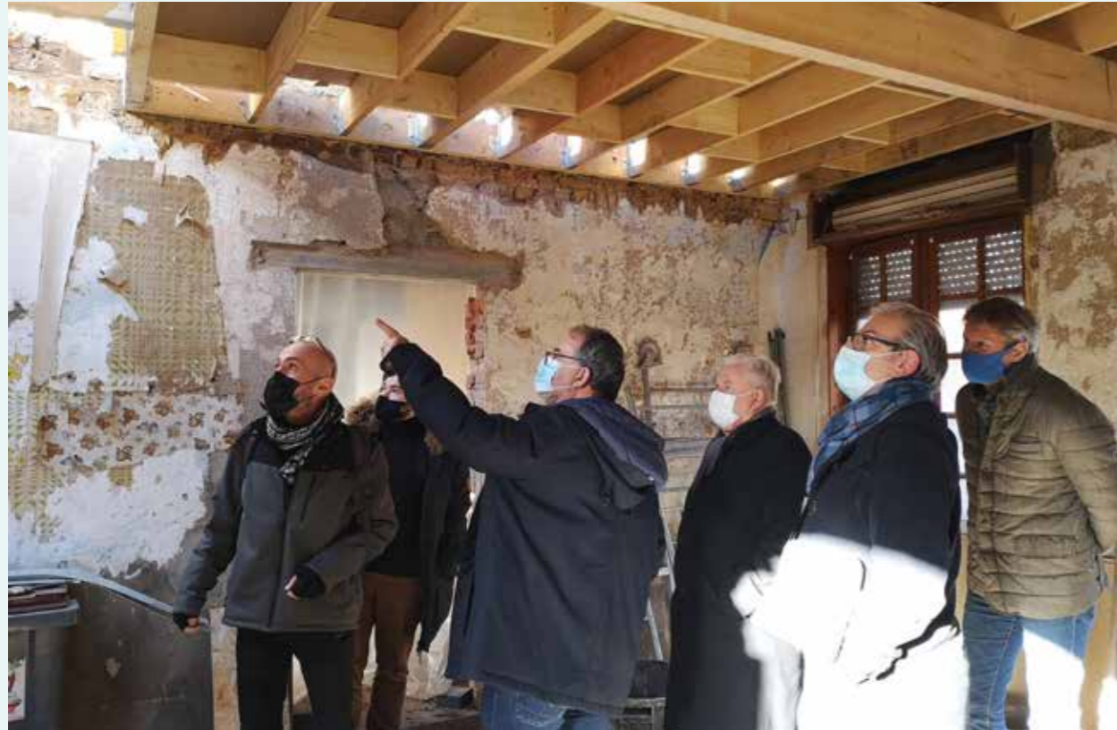
Visite d'un immeuble en cours de réhabilitation.
