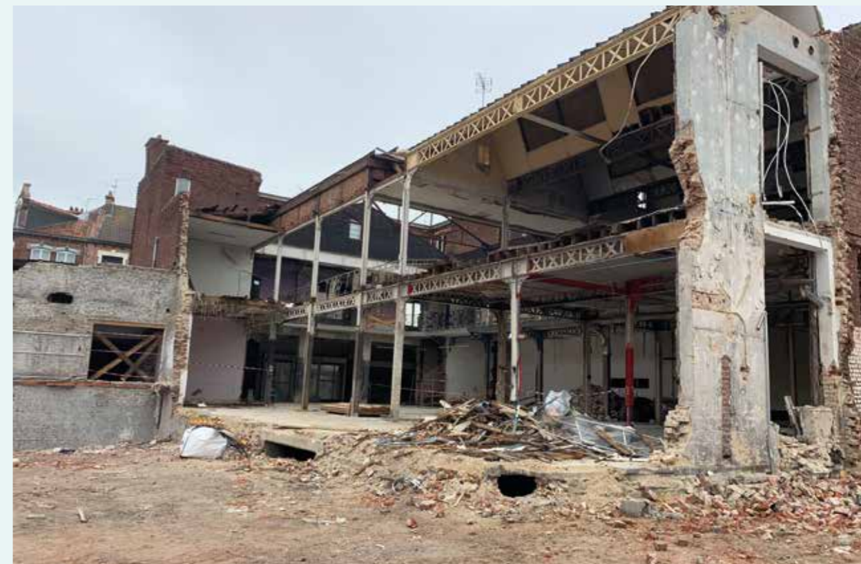
Déconstruction d'immeubles réalisée par EPF Hauts-de-France pour la réalisation de constructions neuves par Habitat du Nord.
