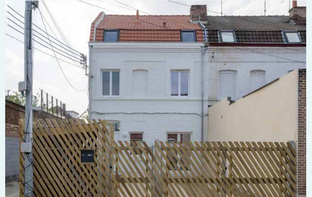
Réhabilitation d'un immeuble sous MOA SPLA pour SIA Habitat - Wattrelos / sam.banchet ©Pierre Rogeaux
