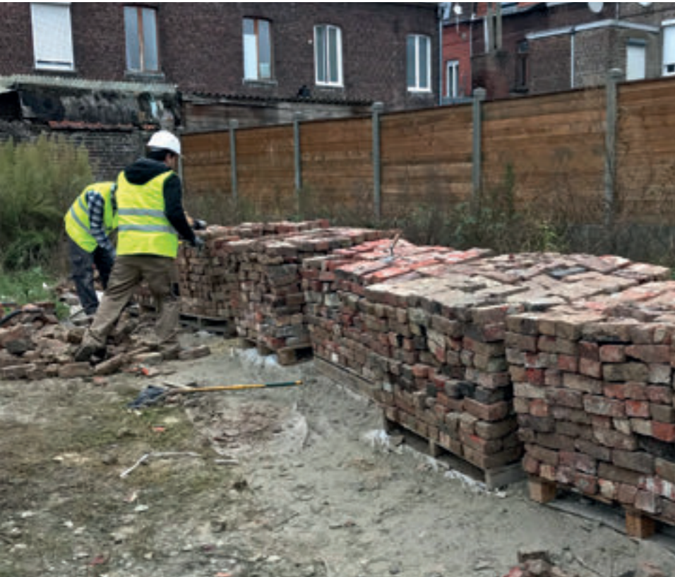
Tri et reconditionnement des briques pour réemploi sur site dans le cadre d'une démarche d'économie circulaire.
