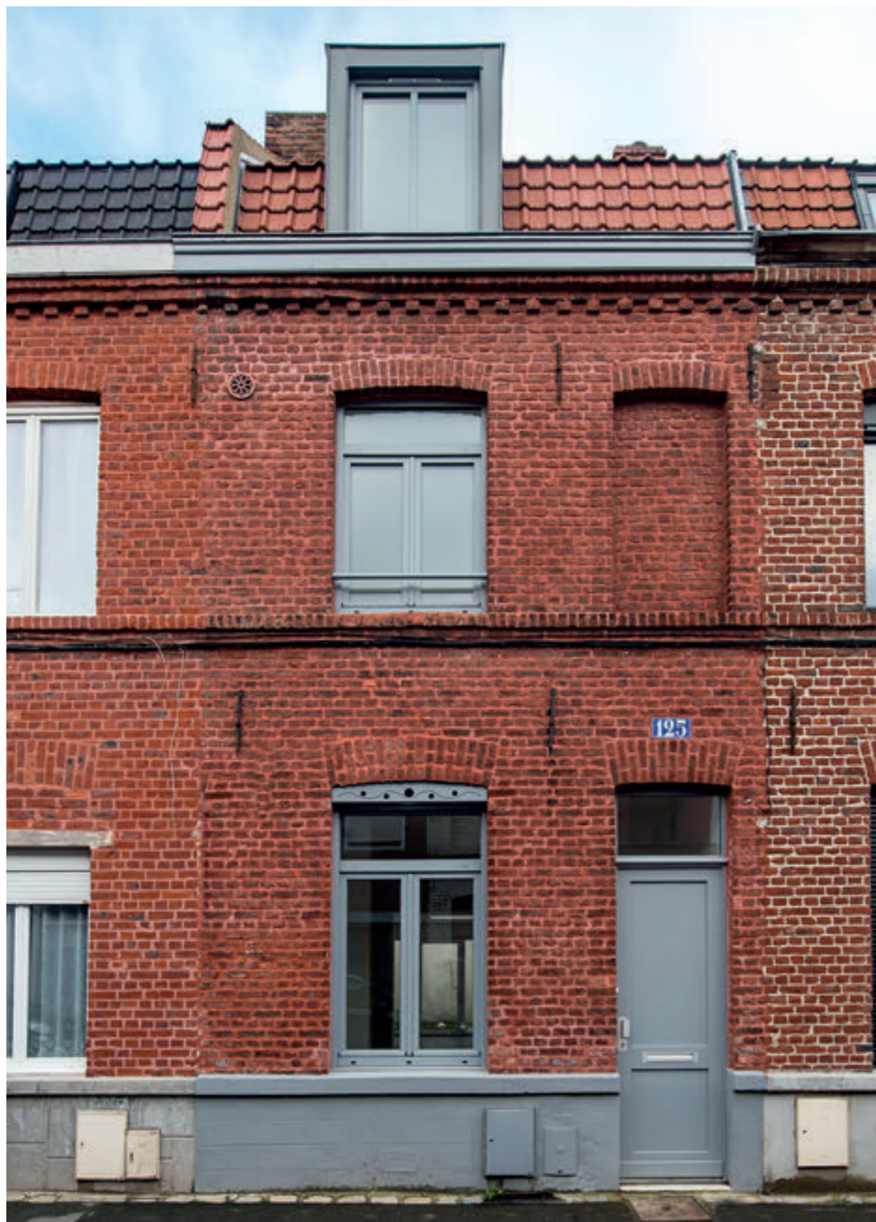
Réhabilitation d'un immeuble sous maîtrise d'ouvrage SPLA- Roubaix ©Sébastien Jarry
