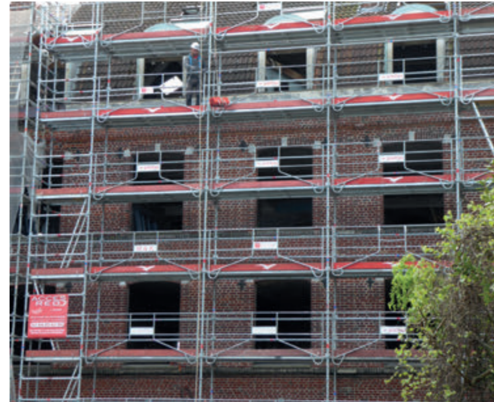
Chantier de réhabilitation du grand collectif par Partenord Habitat @SPLA
