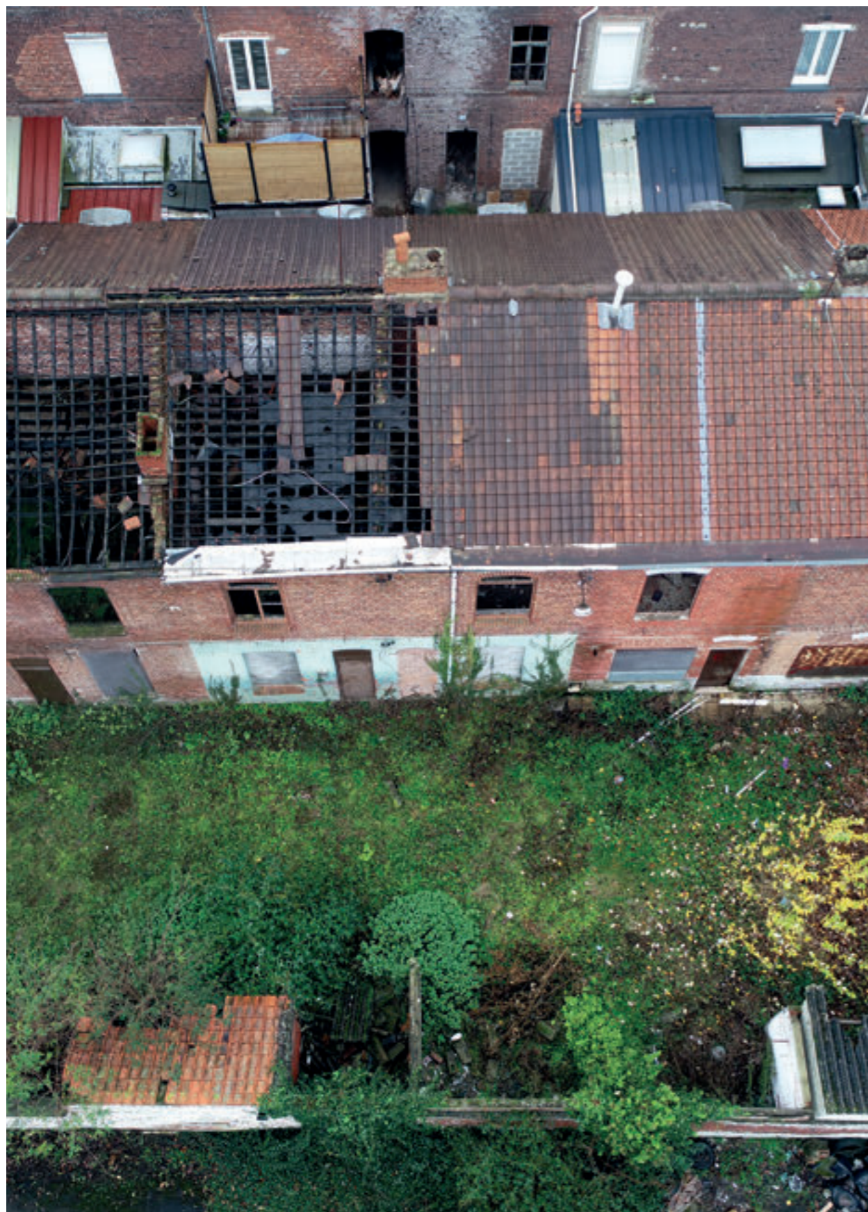
Étude pré-opérationnelle RHI. Vue aérienne du secteur Breuvert, Armentières
