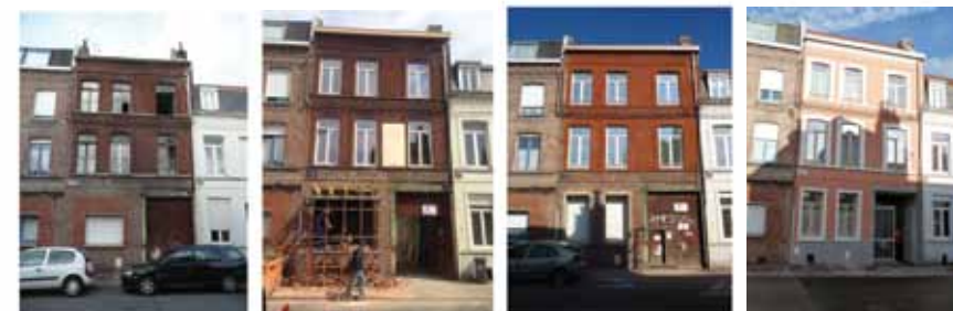
Le chantier du 60 rue de Condé à Lille Debarge & Bellaigüe Architectes associés
